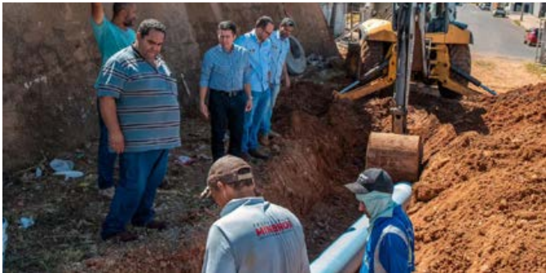
Obras da adutora que leva água para o reservatório do Setor Aeroporto: antiga tubulação está sendo substituída por uma nova rede de 300mm de PVC — Foto: Reprodução.
